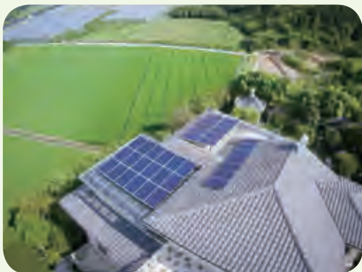
农户屋顶光伏发电设备安装完工
