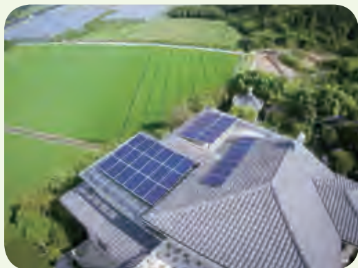
农户屋顶光伏发电设备安装完工
