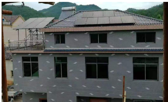
图：罗家乡席家村“太阳能光伏发电”项目，村民可获得屋顶租金和节约电费双重收益
