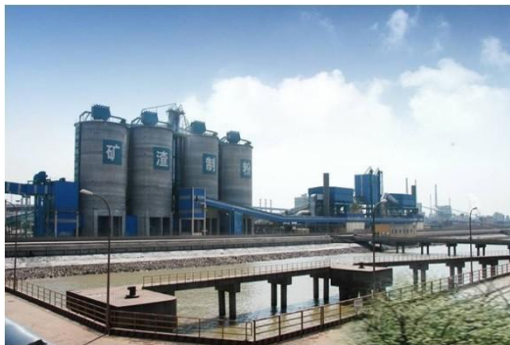
图：江苏沙钢集团矿渣制粉生产线
